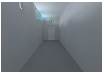
Bild 3.16b: Indirekt strahlende Sicherheitsleuchte
